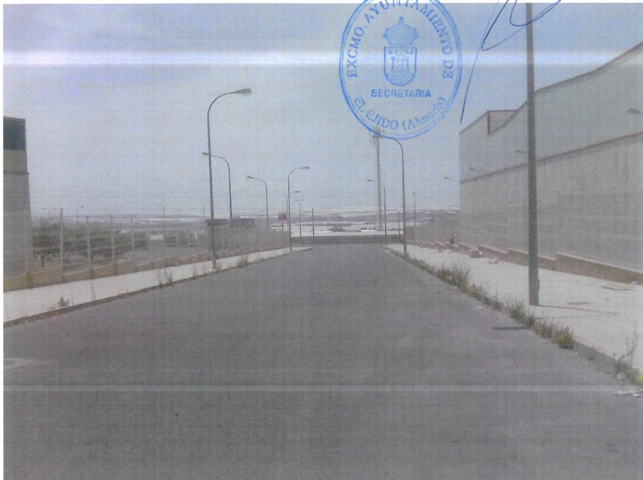
Vista del vial desde Rotonda Norte
