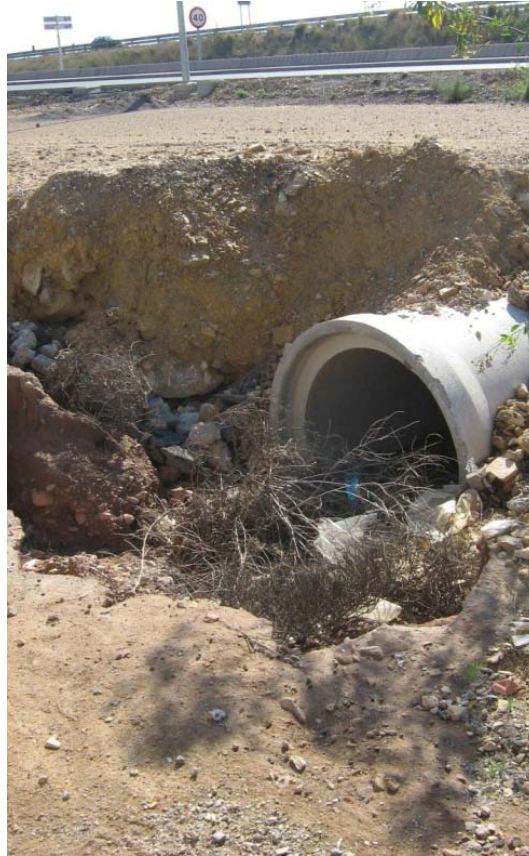
Foto 3. Imágenes del extremo de la canalización existente bajo la vía de servicio. En este punto es donde se conectarán las redes de pluviales de las urbanizaciones.
