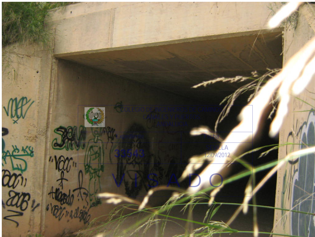
Foto 8. Drenaje transversal de la Autovía, consistente en un cajón de hormigón de 3,00 x 2,50 m.
