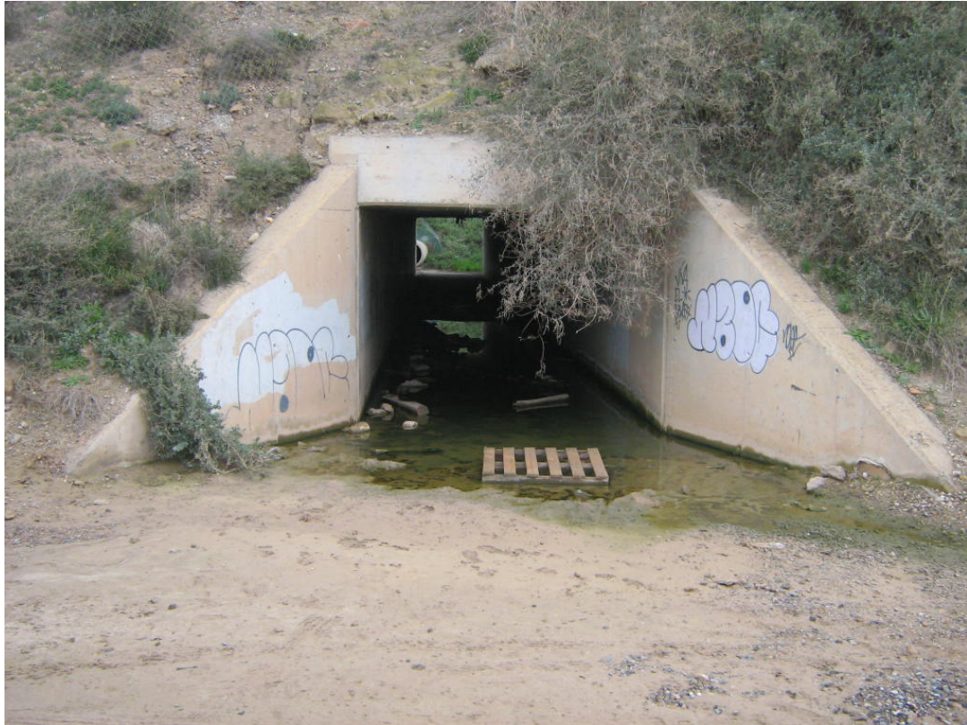
Foto 9. Imagen de la obra de drenaje transversal desde el otro lado de la Autovía.
