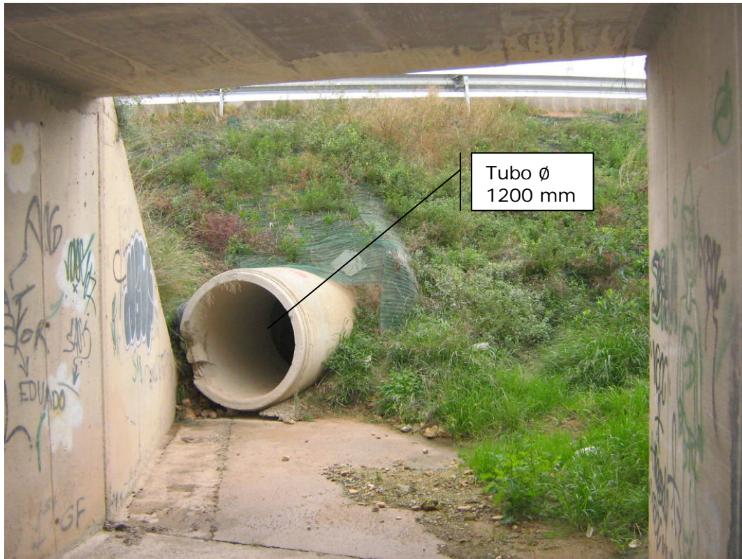
Foto 7. Desembocadura del tubo de \varnothing 1200 mm en la embocadura del cajón. Hay que anular dicho tubo.
