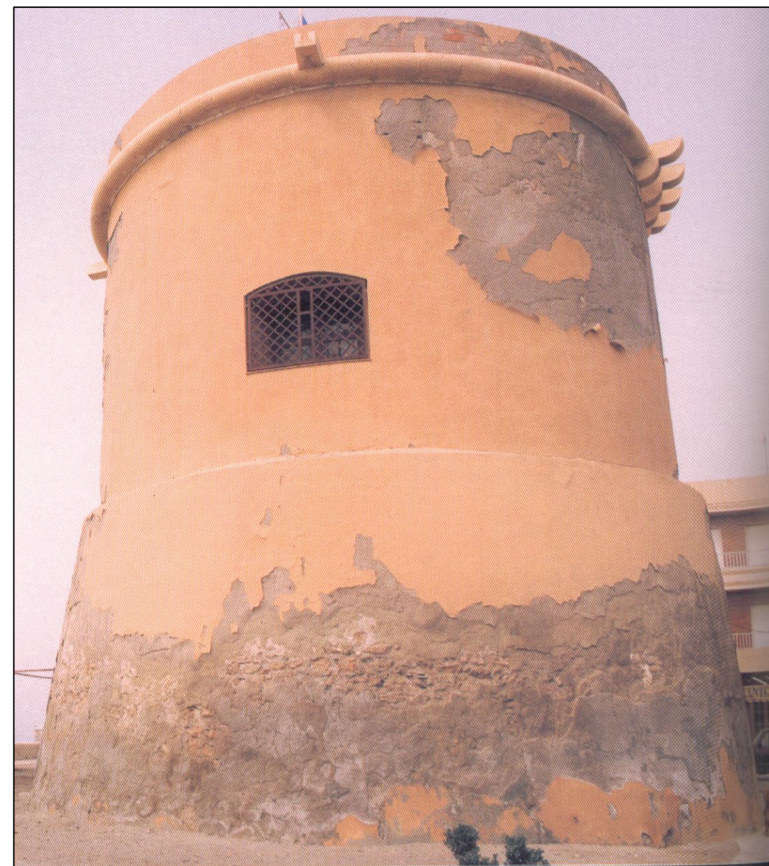
TORRE DE BALERMA. MO-02-2
