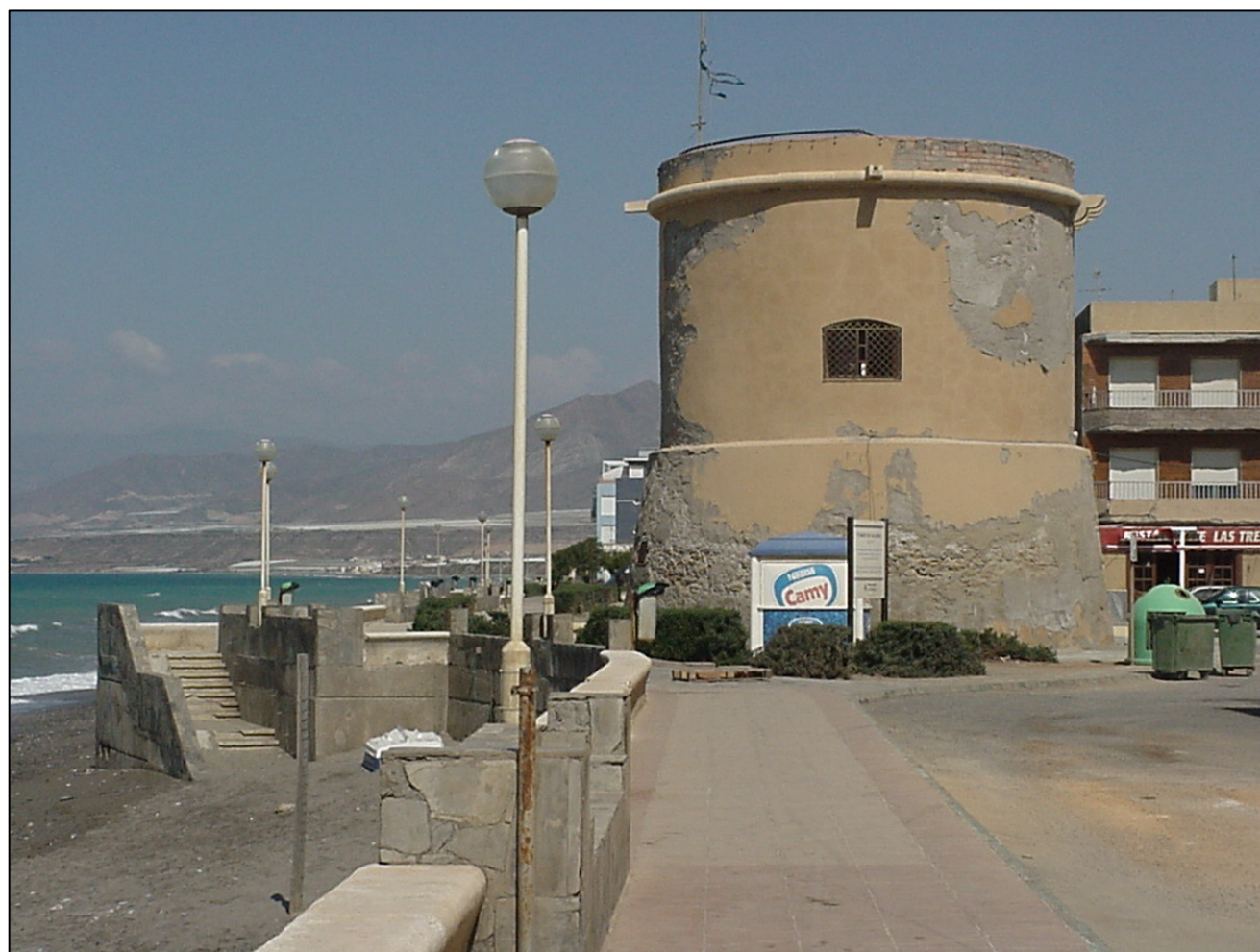
TORRE DE BALERMA. MO-02-1
