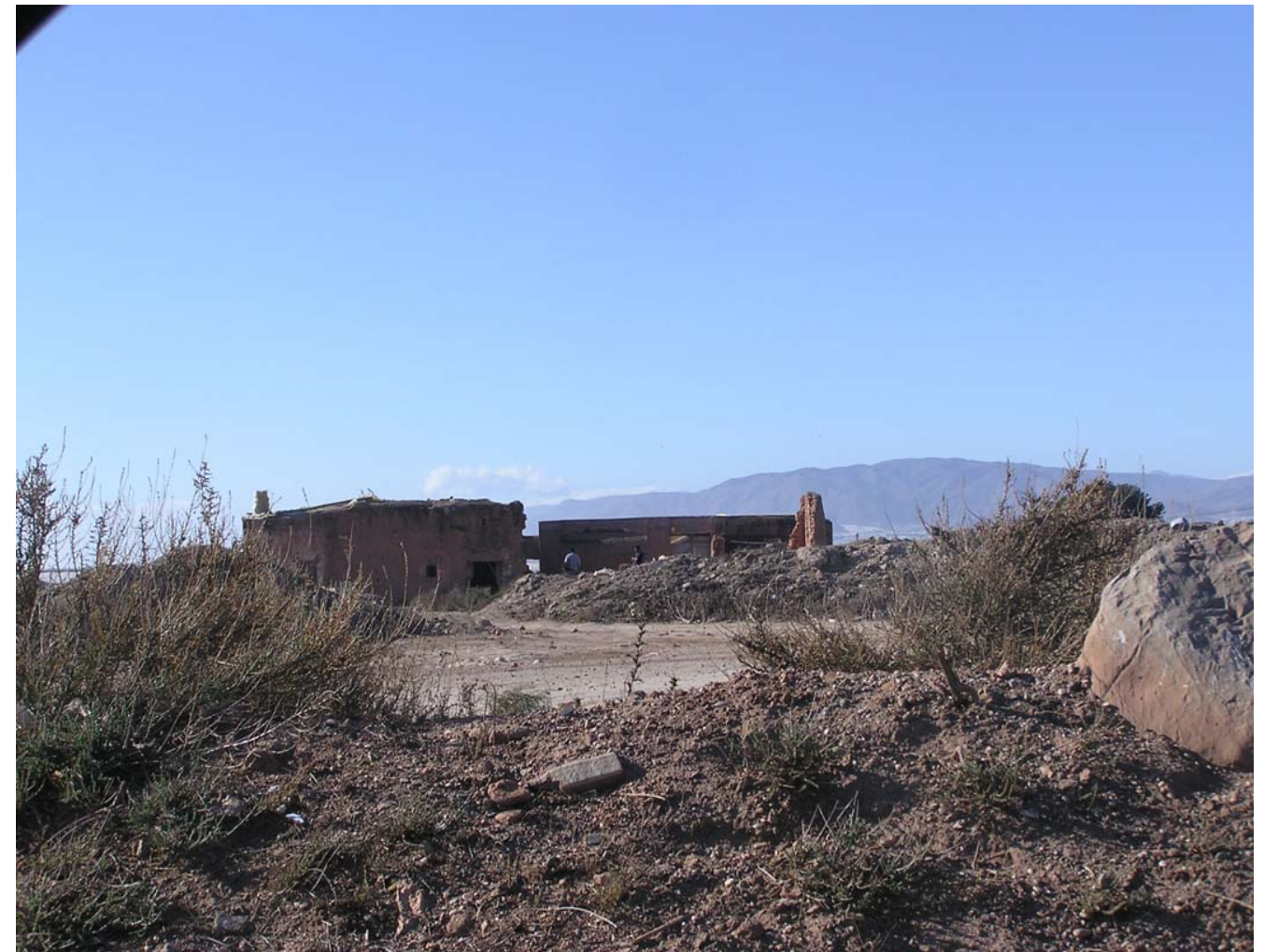
VISTA GENERAL DEL ESTADO DEL CORTIJO JIMÉNEZ
