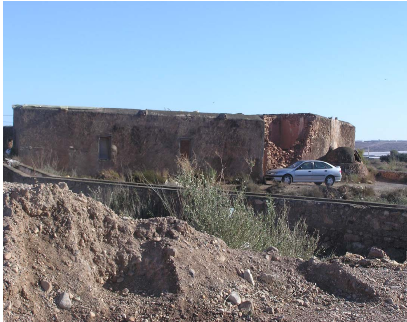
VISTA GENERAL DEL ACUEDUCTO
