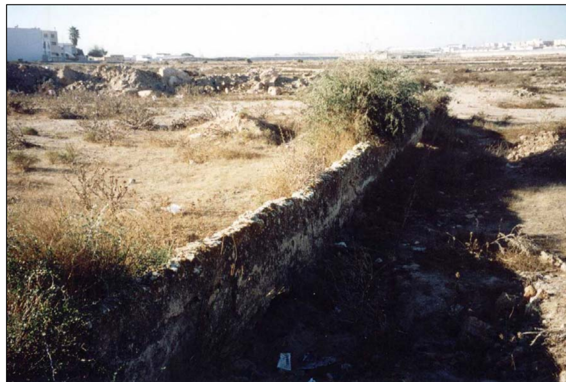
MURO DEL EMPALME DE ACACIAS / MURGI. C3.11
