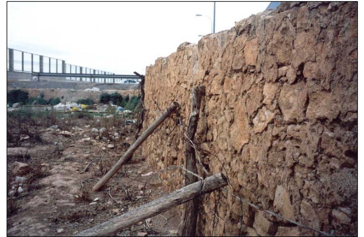
ALREDEDORES DEL CERRILLO ( MURGI ). POSIBLE ACUEDUCTO. C2.20
