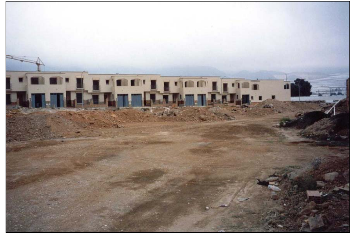
CAMINO DE LOS ALJIBILLOS B ( MURGI ). C2.14
