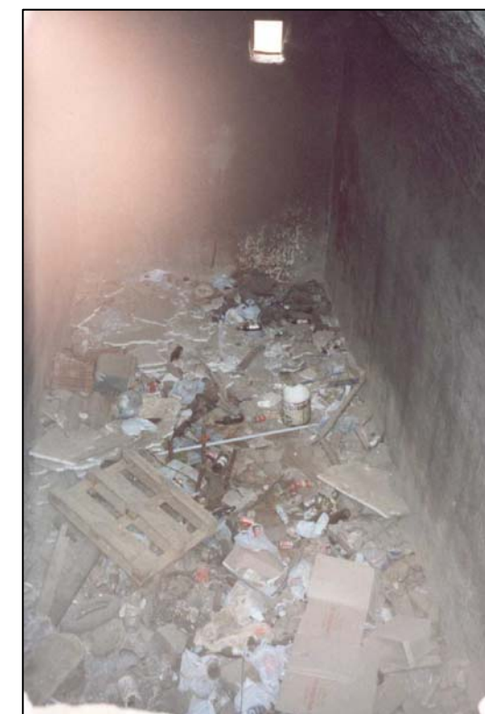
ALJIBE CARRETERA DE MALAGA-PASEO DE LOS POETAS. C2.11
