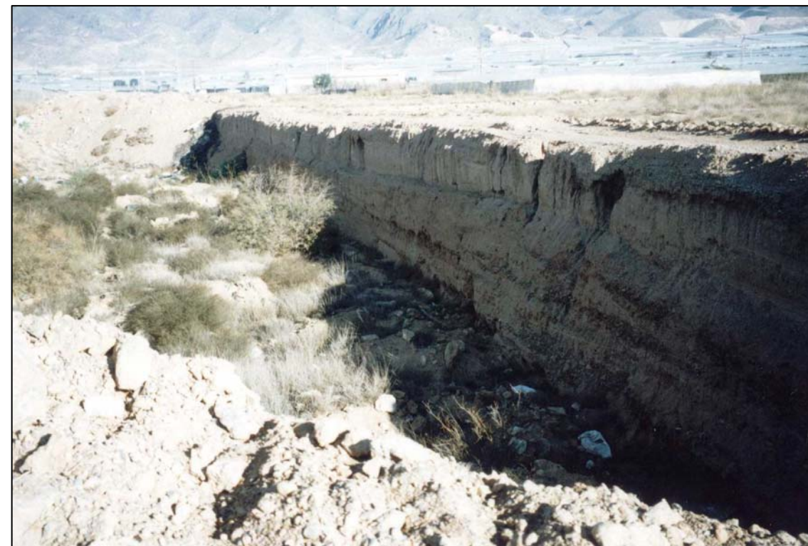
SOCAVON DE MERCOALMERIA (MURGI)/AV. INFANTA CRISTINA-CALLE EMPERADORES. C7.7
