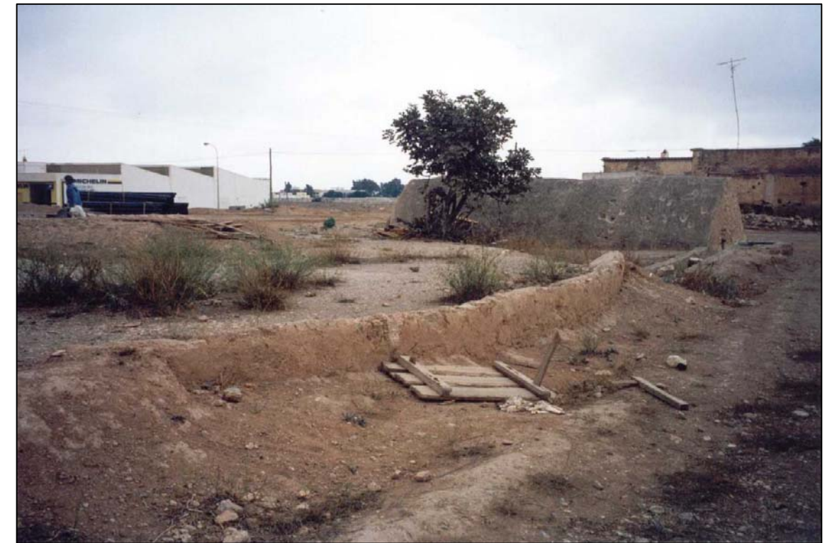
ALJIBE CARRETERA DE MALAGA-PASEO DE LOS POETAS. C2.6
