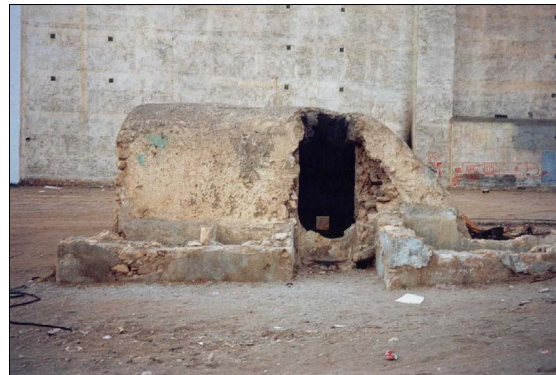
ALJIBE CARRETERA DE MALAGA-PASEO DE LOS POETAS. C2.10
