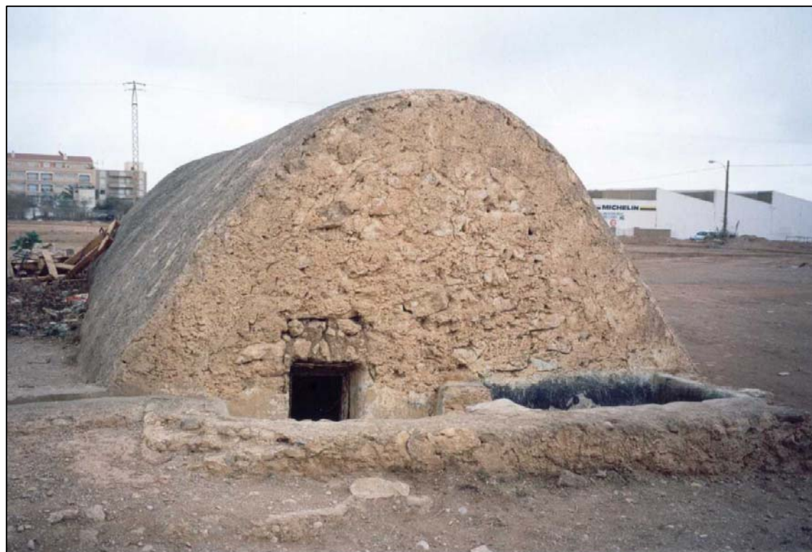
ALJIBE CARRETERA DE MALAGA-PASEO DE LOS POETAS. C2.8
