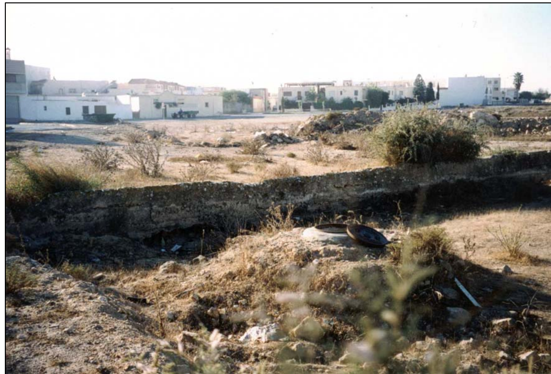
MURO DEL EMPALME DE ACACIAS / MURGI. C3.10
