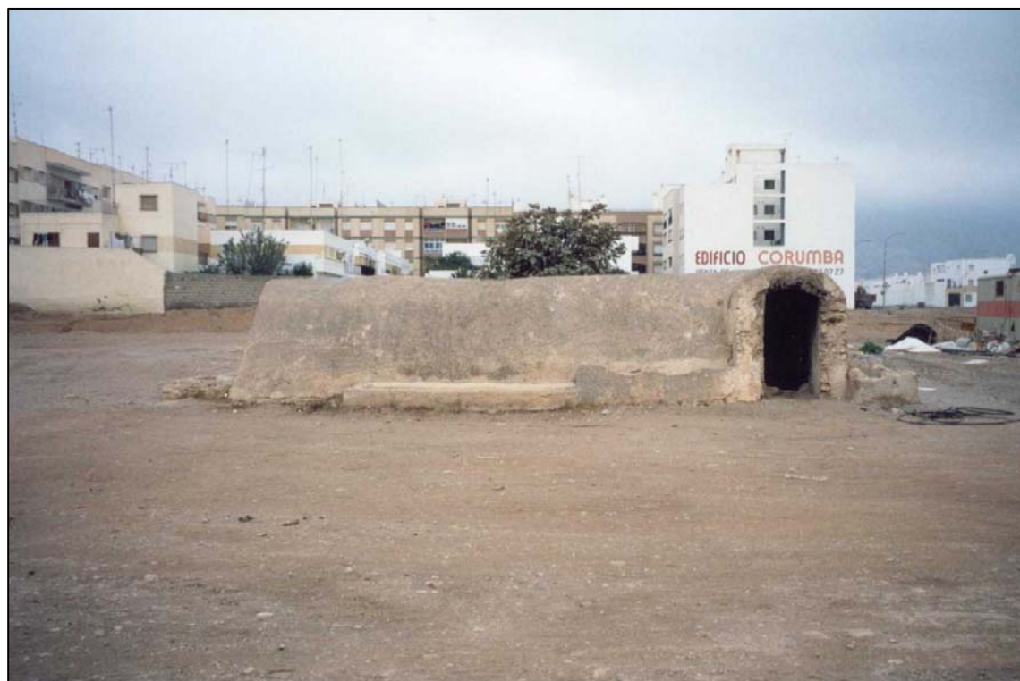
ALJIBE CARRETERA DE MALAGA-PASEO DE LOS POETAS. C2.9
