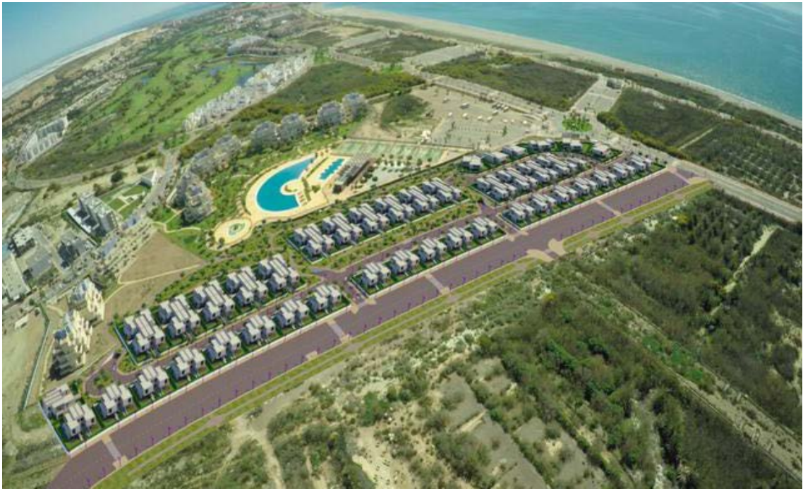
Imagen aérea 3D de la implantación de la propuesta en la parcela organizada en 7 manzanas construibles rodeadas de espacios verdes, con gran permeabilidad hacia las zonas verdes y espacios libres centrales
