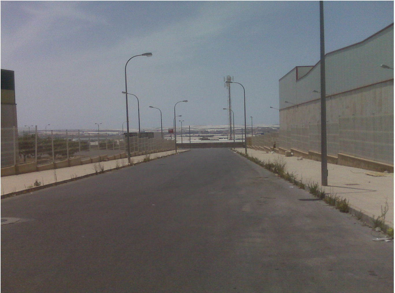
Vista del vial desde Rotonda Norte
